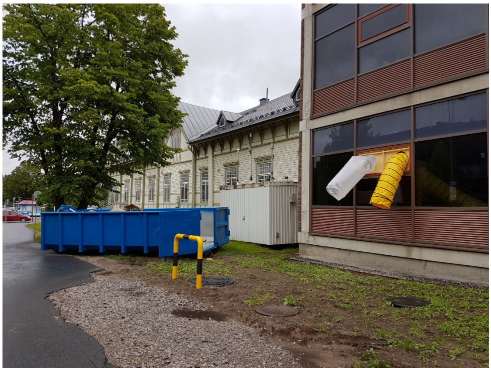
Kuva 25. Kesällä ja syksyllä 2018 kaupungintalon alakerrassa oli remontti ja Lönnrotinkadulla tehtiin katutöitä. Kuva 28.6.2018: Tarja Laatikainen, Kajaanin kaupunki.
