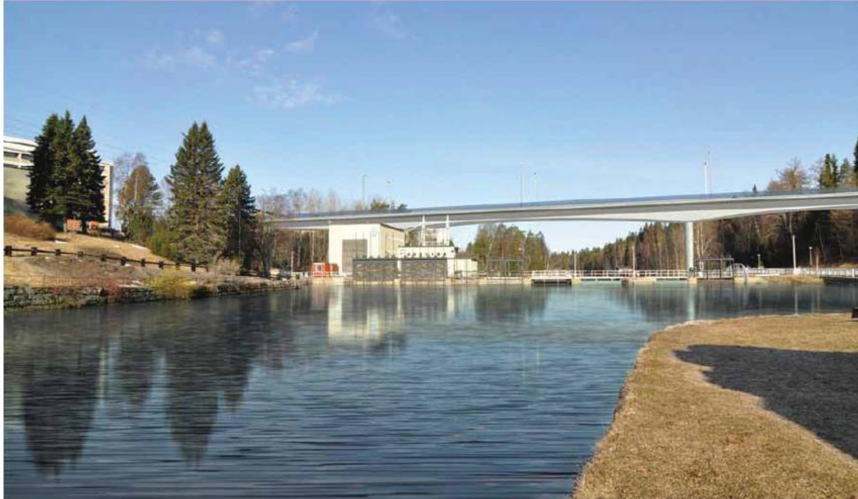
Liittorakenteinen jatkuva palkkisilta, jossa viisteellinen muoto. Perinteinen aukeahkojen vesistösiltaipaikkajen perusratkaisu.
