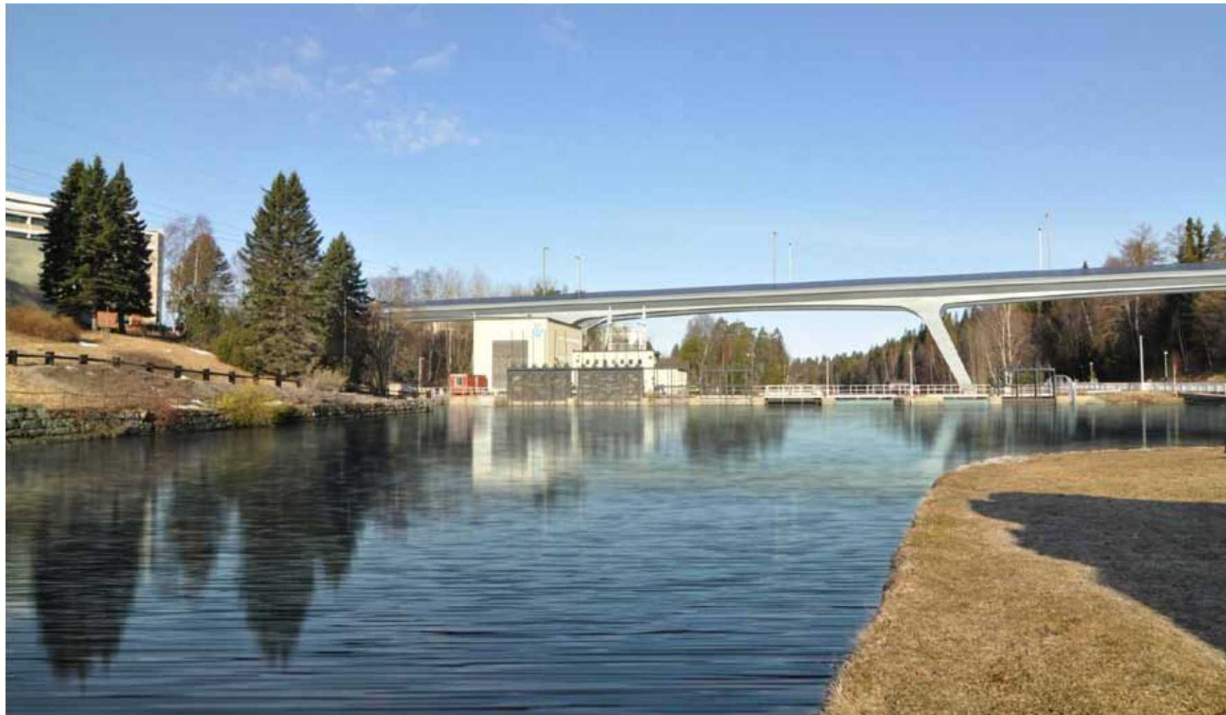
Teräsbetoninen kehäsilta, muuttuva palkin korkeus, kansirakenne laattapalkki. "Funkkis-muotoilu".
