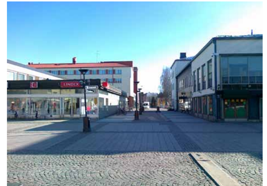
Kuva 37: Raatihuoneen torin vesikouru on osan vuotta peitettyä vaarallisuutensa vuoksi.
