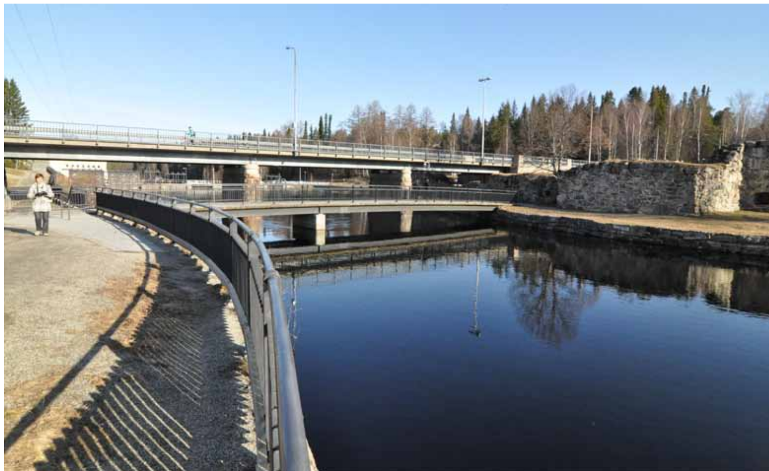
Kuva 69: Vuonna 2003 valmistui Linnasaarelle erillinen kevyenliikenteen silta.
