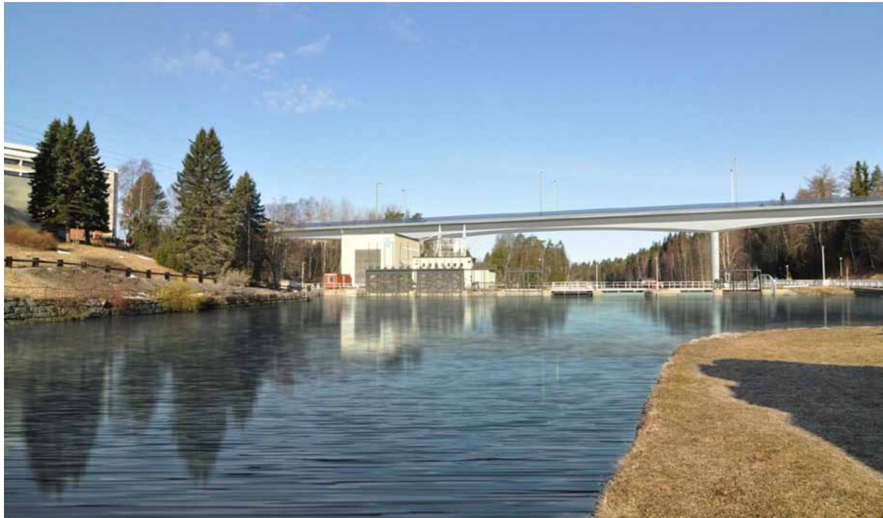
Liittorakenteinen jatkuva palkkisilta, jossa viisteellinen muoto. Perinteinen aukeahkojen vesistösiltaapaikkojen perusratkaisu.
