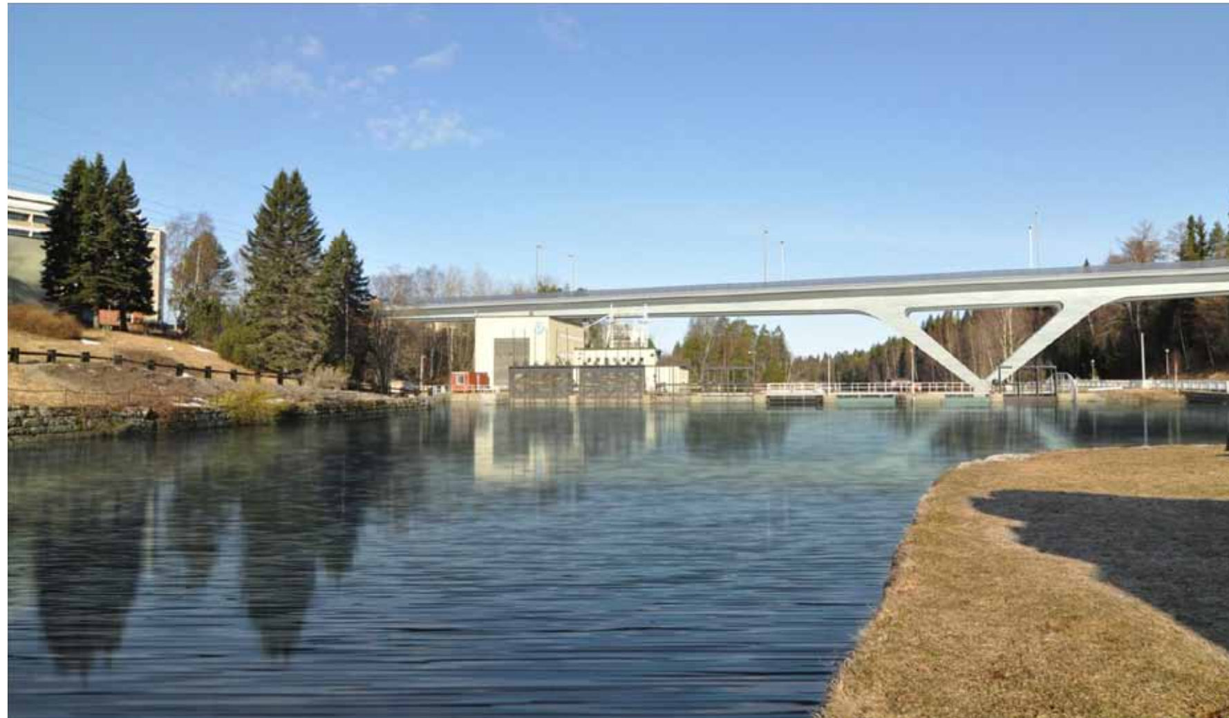
Teräsbetoninen laattapalkkisilta, suoraviivaisesti muuttuva palkin korkeus. Muotoilulla korostettu välituki. Silta on mahdollista toteuttaa myös teräsrakenteisena (kansipalkit ja välituki T3)
