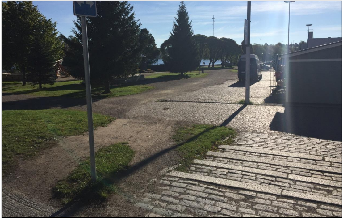
Kuva 12. Torin ohi kulkevat pyöräily-yhteydet ja Lönnotinkadun ylitys ovat puutteelliset ja aiheuttavat toistuvasti liikenneturvallisuusongelmia.
